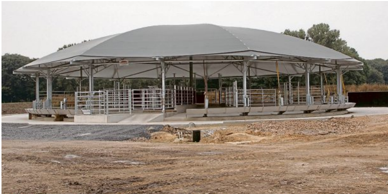
Ein echter Hingucker: Der runde Rindermaststall bietet Platz für etwa 140 Tiere und ist nach allen Seiten offen. Mitten im Gebäude ist die „Verteilstation“. Ulli Krumkühler demonstriert, wie die Tiere dort mit Schwenktoren geleitet werden.
