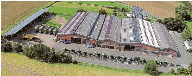
Betriebsgelände der Firma Lorenz Rubarth Landtechnik
