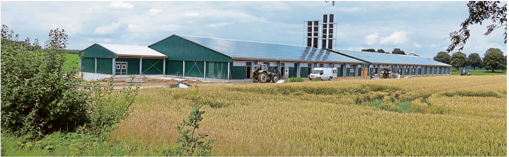
Das neue Gebäude ersetzt mehrere Altbauten und gliedert sich in Verladebereich, Ferkelstall, Hygieneschleuse, Abferkelstall, Deckzentrum, Wartestall (von links).
