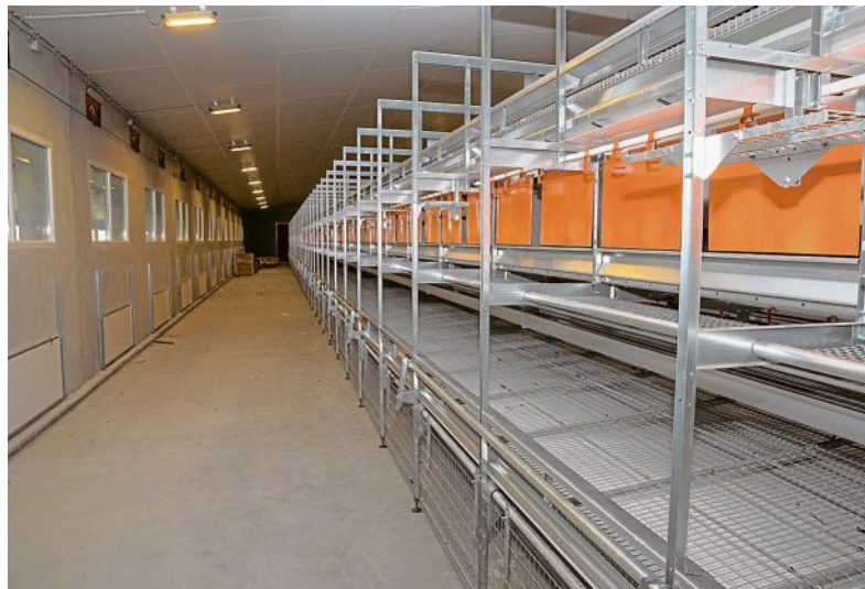
Die Legehennen können künftig frei zwischen Auslauf und Technikbereich mit Familiennest, Futter- und Tränkelinie sowie Kot- und Eiersammelband wechseln.
