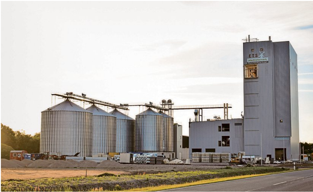
Das neue Mischfutterwerk in Ladbergen ist gut an Autobahn und Dortmund-Ems-Kanal angebunden.
