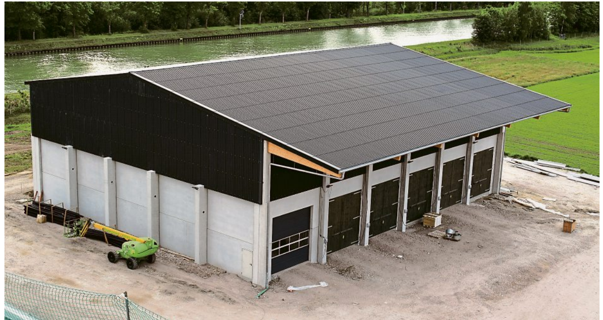
In der Lagerhalle mit fünf Parzellen kann das ETS Mischfutterwerk insgesamt 6000 t Schüttgüter lagern. Für abgesackte Ware auf Paletten ist dort außerdem ein Hochregallager entstanden.
