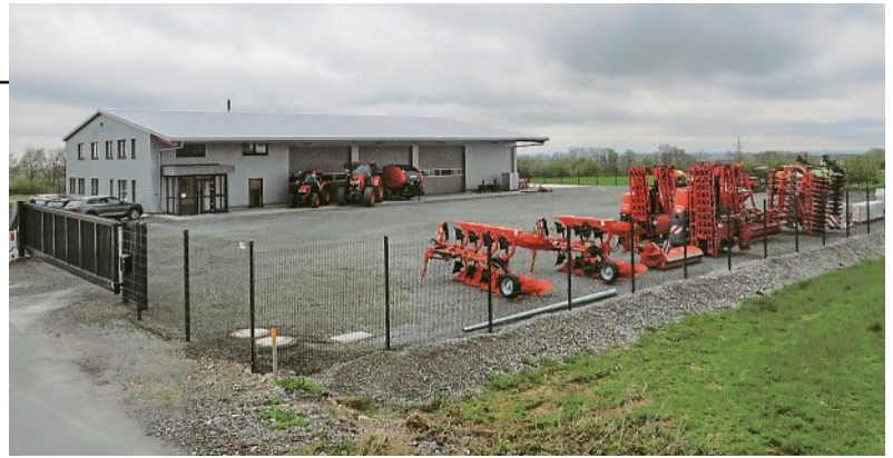
Das neue Betriebsgelände des Unternehmens an der Deutzstraße in Anröchte umfasst rund 4000 m 2 mit der Option auf Erweiterung.
