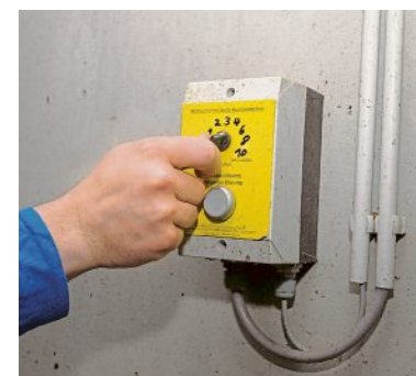
Der Intervallschalter für die Dosierung wird manuell verstellt.
