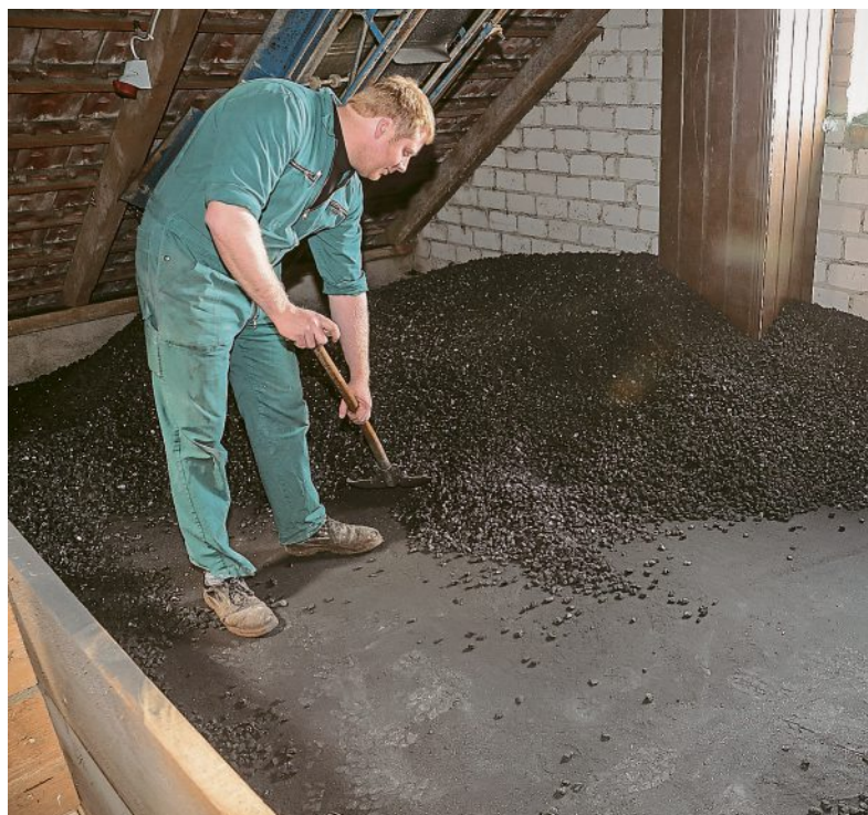
Im Vorratsbunker können bis zu 350 kg Anthrazit- oder Steinkohle gelagert werden. Das entspricht einer Brenndauer von 80 bis 100 Stunden.
