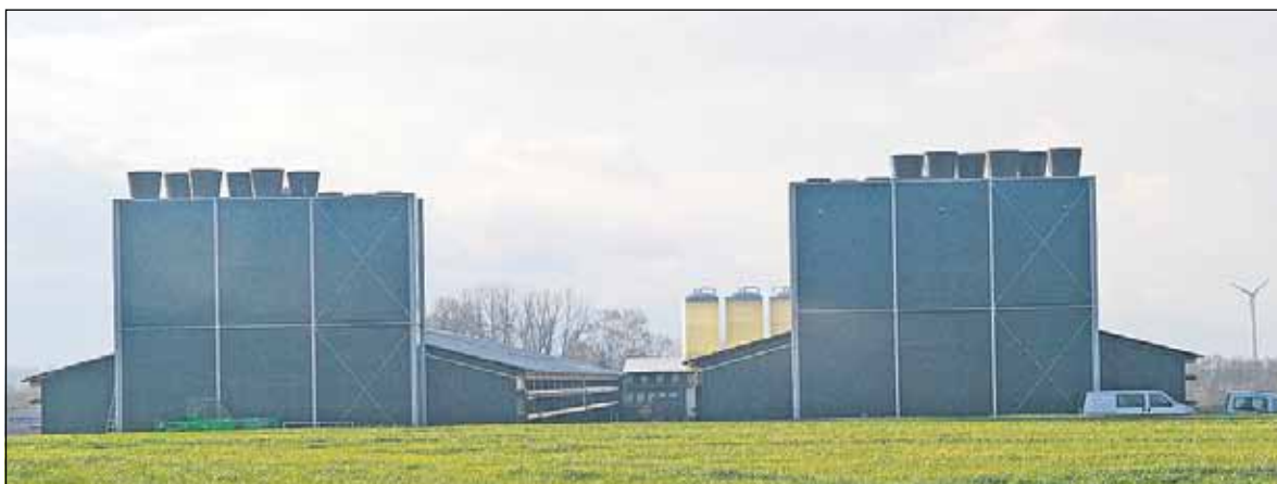
Blick von der Rückseite: Die Abluft wird über zentrale Ablufttürme nach außen geleitet.
