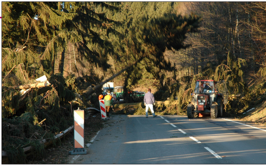
Gefährlich: Noch immer müssen an den Straßen Bäume gefällt und weggeschafft werden.
